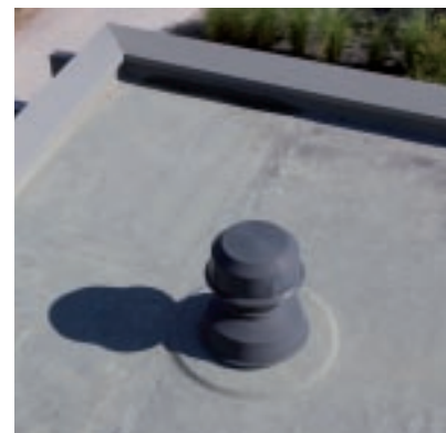
Details werden mit einer Flüssigabdichtung nahtlos in die Fläche eingebunden.
