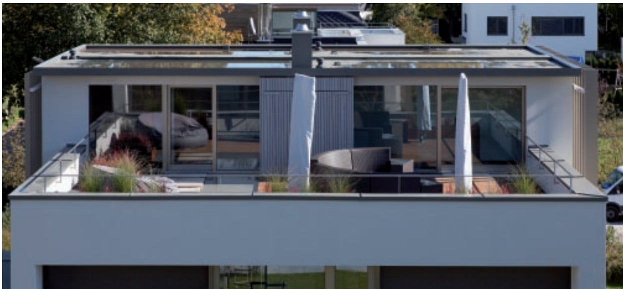
Eine Besonderheit stellt die architektonische Konstruktion des Dachgeschosses dar. Anstelle der vorherrschenden Satteldächer wählten die Architekten ein Null-Grad-Dach und führten die Gebäudeteile rechts und links davon als Staffelgeschosse aus.
