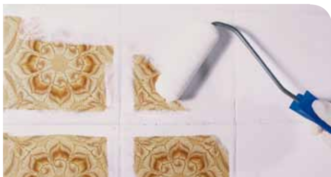
Ohne große Abbrucharbeiten zu einem neuen Badezimmer.
