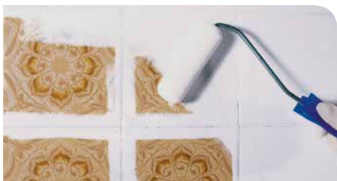
Ohne große Abbrucharbeiten zu einem neuen Badezimmer.
